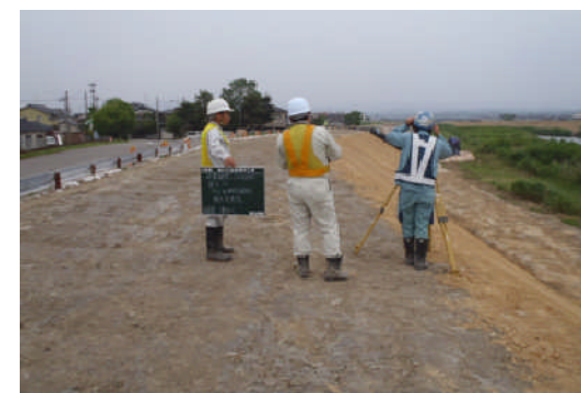
工事基準点 (T5-7) 検測
