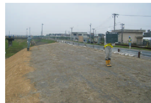
工事基準点 (T5-7) 検測
